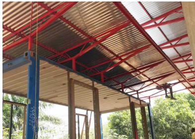
Dachkonstruktion, wie Hauptgebäude
