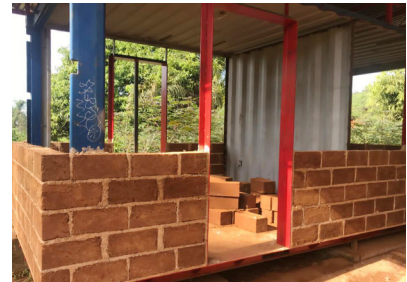
Die Wände werden aufgemauert
