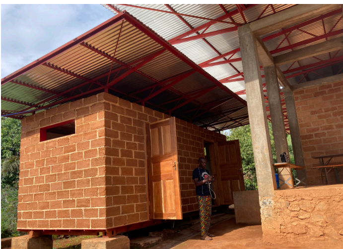
Der fertiggestellte Containerumbau neben dem Hauptgebäude
