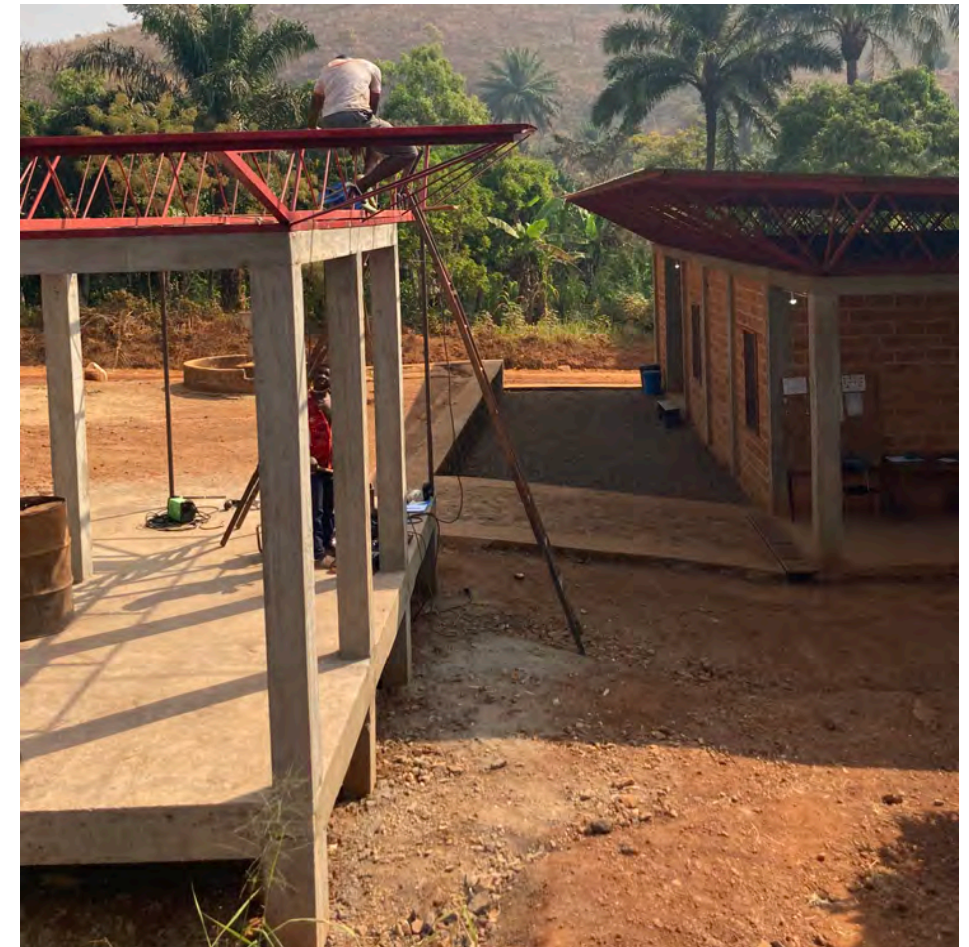
Links: Arbeiten am Rohbau (Zustand Ende Januar 2023) neben dem Centre
